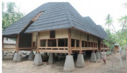
RUMAH LAYAK HUNI: Sejumlah rumah Sarhunta yang hampir selesai dikerjakan dari Kementerian PUPR di KSPN Mandalika yang berada di Desa Gili Indah Pulau Gili Air.
